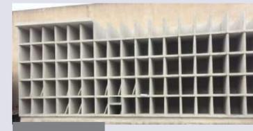
Osarios de hormigón prefabricado
